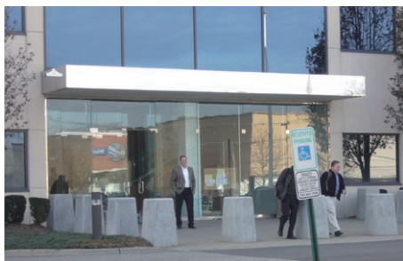
写真1 看板がなくパイロンの立つ玄関
